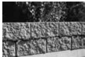
4. Vytlačovanou maltu odstraníme až po mírném zavadnutí, zabrání se tak možnému znečištění tvárnic.
