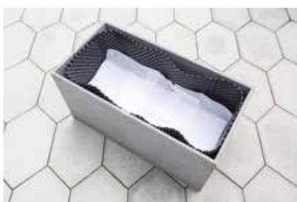
Položení filtrační a oddělovací vrstvy (separační geotextilie např. Flortex 80 g/m<sup>2</sup>) na druhou drenážní vrstvu z keramzitu před uložením substrátu.
