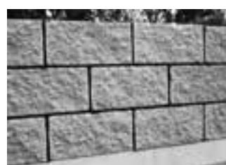
HOТОVÉ ZDІVO: při precizním uzavření spár jsou spoje odolné vůči povětrnostním vlivům a mrazu a konstrukce po vyzrání výplňového betonu působí jako jeden monolitický celek.
