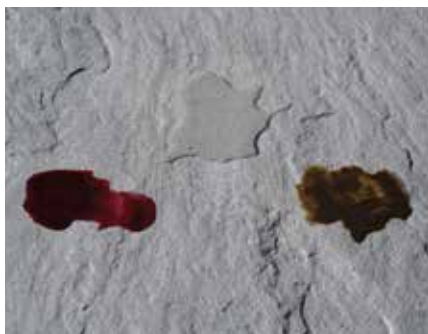
Znečištění – víno, vyjetý olej, voda
