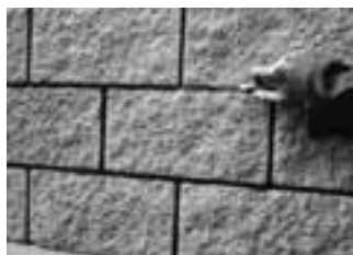
5.-6. Zdění a spárování probíhá v jedné operaci. Povrch spár se uzavře uhlazením spárovacím hladítkem nebo upraveným dřevěným kolíkem.
