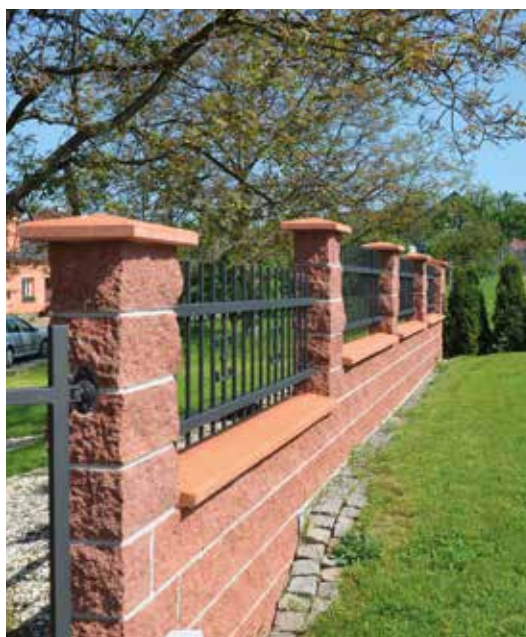
Zákrytová deska sloupková, průběžná – cihlová
